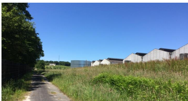
Vue sur les chais actuels depuis le Sud
